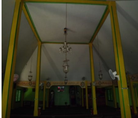
Gambar 5: Empat tiang penyanggah (kolom) yang asli masih dipergunakan (Foto Dok. Kasim)
