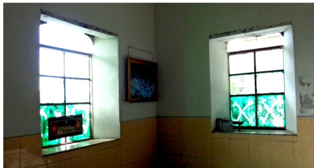
Gambar 4: dinding dan jendela masjid (dokumen pribadi)
