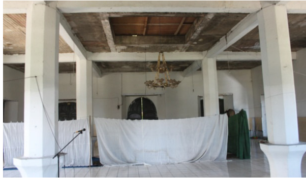
Gambar 8: Ruang jamaah dan pilar (dokumen pribadi)
