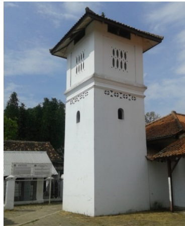
Gambar 18: Menara Masjid Kasunyatan di sebelah barat Bangunan Masjid (Foto: Asep, 2017)
