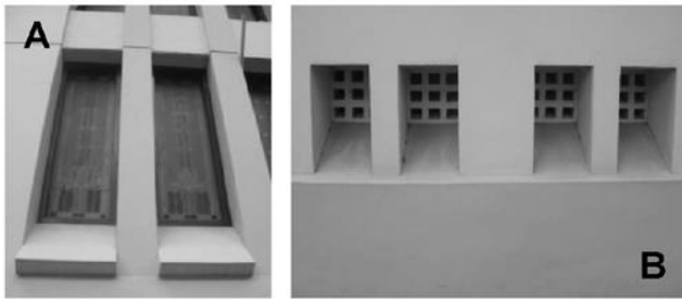
Gambar 11. Ventilasi gereja GPIB Bethel pengaruh art deco Sumber: Krismanto Kusbiantoro, 2007
