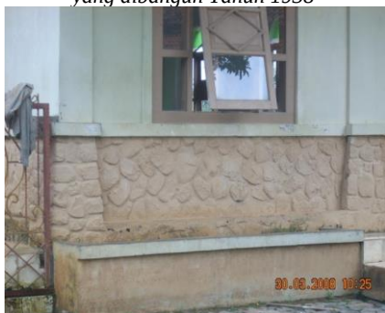
Dinding Masjid Santi Asromo yang dibangun Tahun 1938
