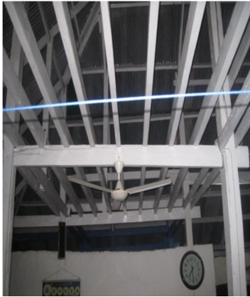
Foto: Lantai dua sebelah selatan, hanya dengan balok tanpa papan, tampak dari bawah
