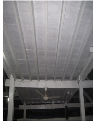
Foto: Lantai dua sebelah utara dengan alas papan, tampak dari bawah
