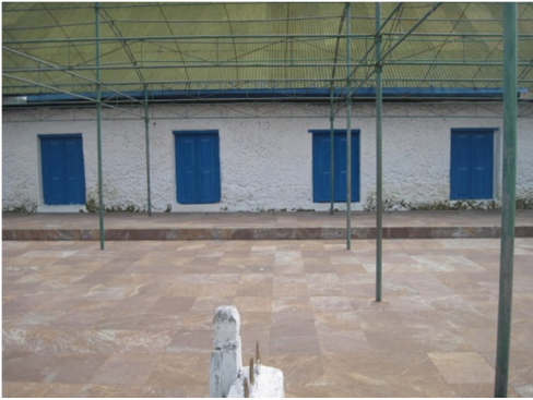
Foto: Empat buah pintu sebelah selatan
