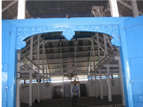
Foto: Kusen pintu utama dengan latar belakang ruang masjid
