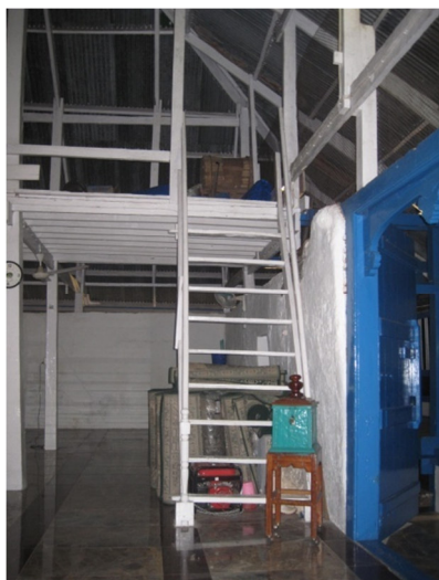
Foto: Tangga I, menghubungkan lantai satu dengan lantai kedua
